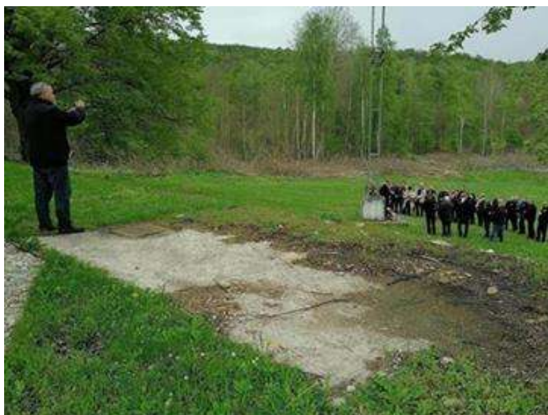
20220424-51_VZ_Vocin_Slatinski_Drenovac_zlocinci_pobili_500_ljudi_jama.jpg Krovna betonska ploča grobnice sa vidnim željeznim „šaftom“
