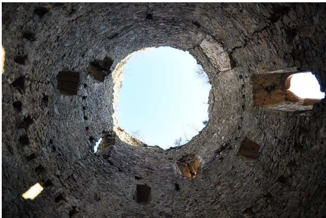
Promjer unutrašnjosti branič-kule je 9 metara, debljina zidova oko 2 metra, a kula je bila visoka 16 metara.
