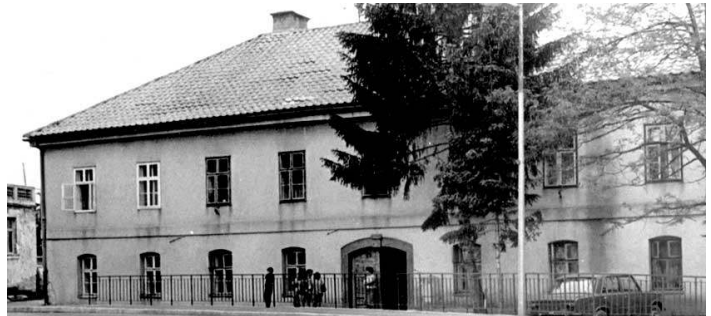
Zgrada nekadašnje gospičke žandamerije pretvorena je u partizanski zatvor
