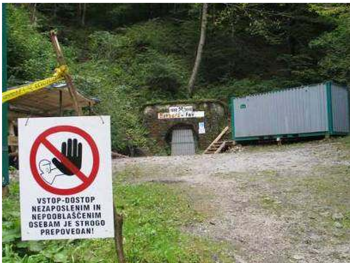
Laško - Spodnja rečica 23.10.2008. g.: radovi na otvaranju Barbarinog rova su zaustavljeni
